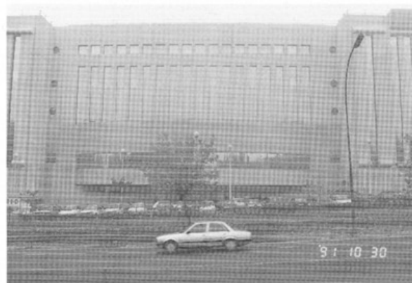
写真・23 郊外のオフィスビル
