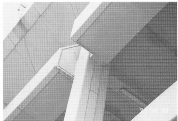
写真・19 同上柱・梁取合部のディテール
