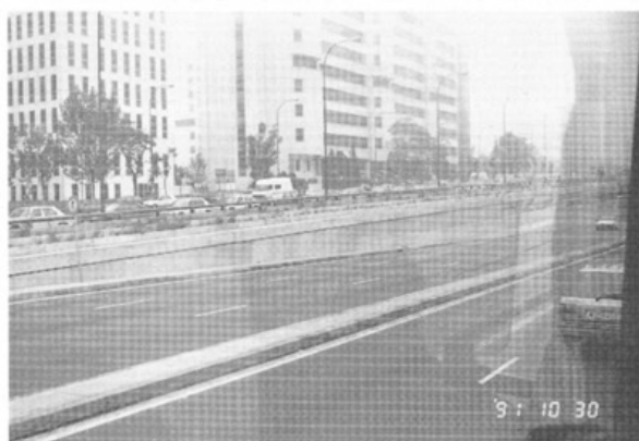
写真・21 市内～郊外の地下道側壁
