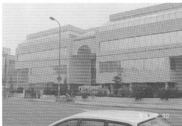
写真・20 郊外のオフィスビル
