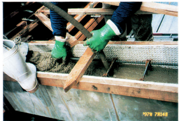
GRC 打込み型枠施工試験
