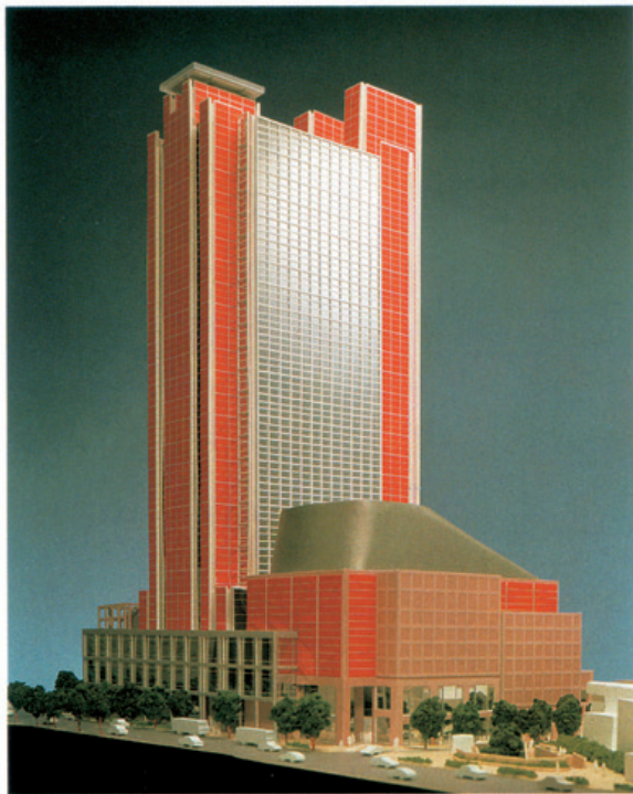
写真-1 三軒茶屋再開発 キャロットビル
