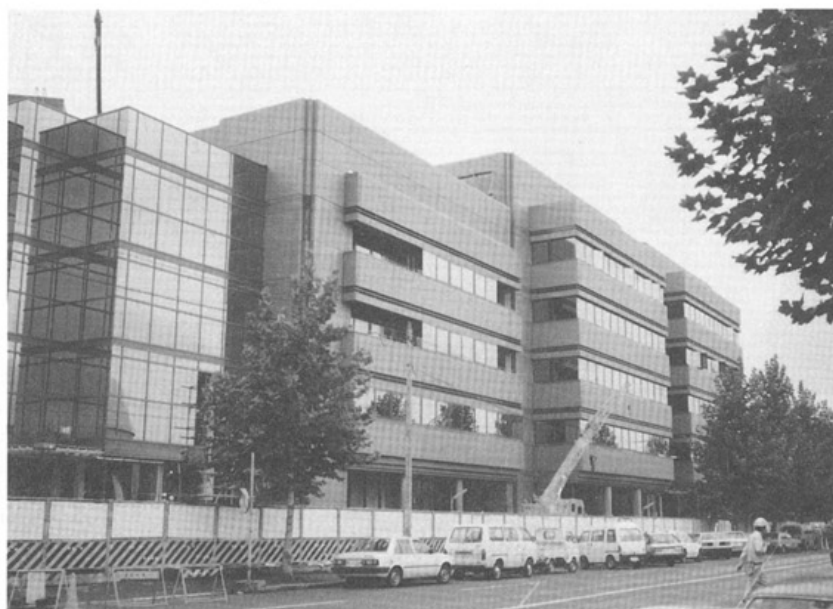
写真は工事中の京都サイエンスセンタービルの外観
