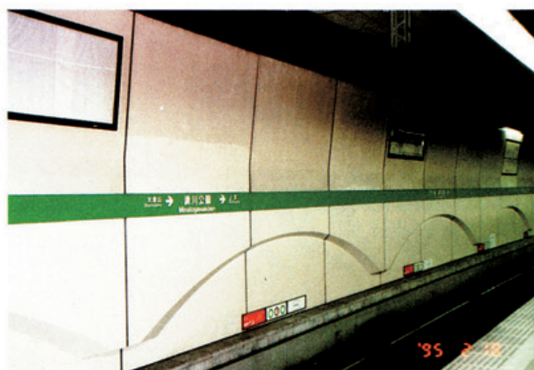
写真2. 地域: 兵庫区地下鉄駅構内 施工時期: 1982年 建物構造: RC造 使用部位: 内壁 数量・サイズ: 278枚 2,498×1,997mm
