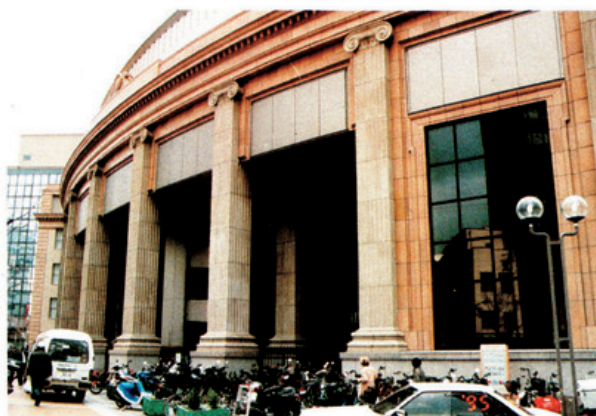
写真1. 地域: 元町 施工時期: 1993年 建物構造: RC造 使用部位: 柱カバー 数量・サイズ: 541枚 1,454×884mm
