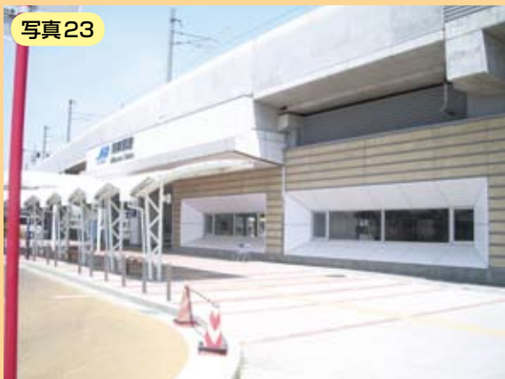
空港線 美田園駅 外壁
