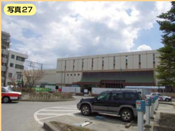
本塩釜駅 外壁
