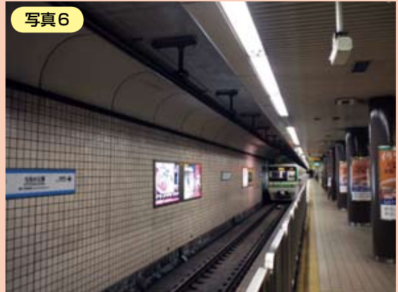
仙台市地下鉄 南北線 勾当台公園駅ホーム階 対向壁 R 付き GRC パネル
