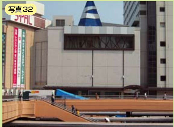
仙台メトロポリタンホテル 外壁亀裂
