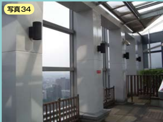
仙台アエル 31F 展望階 梁・柱 GRC カバー
