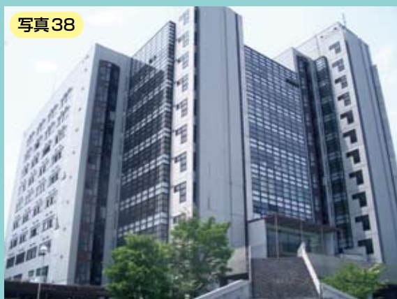
東北大学構内被災状況
