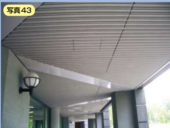
国際交流センター 軒天 GRC パネル
