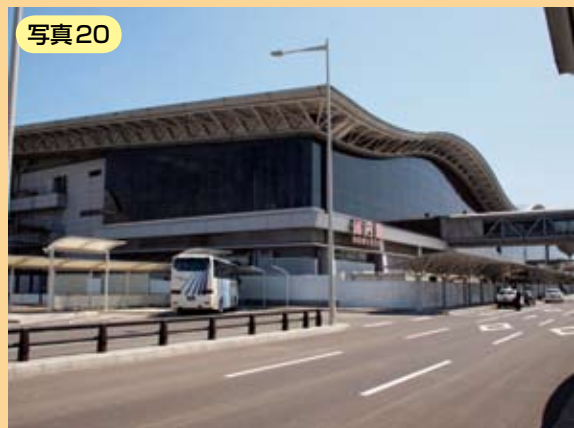
仙台空港 外壁
