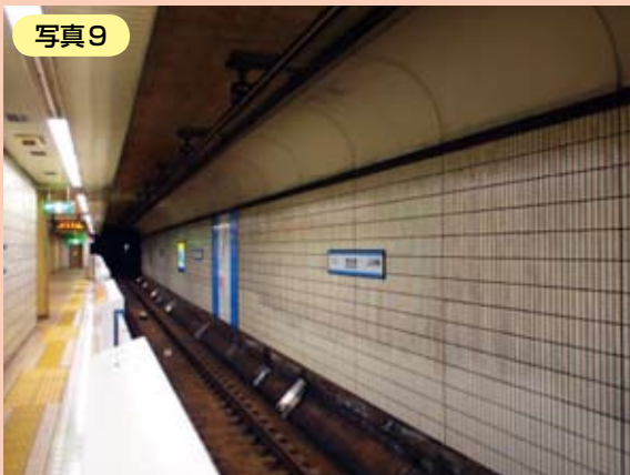
仙台市地下鉄 南北線 愛宕橋駅ホーム階 対向壁 R 付き GRC パネル
