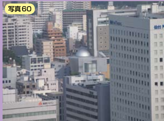
メルパルク仙台 GRCドーム遠景
